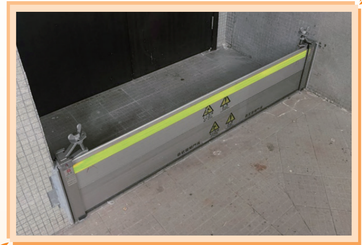
富豪機場酒店的防洪閘
