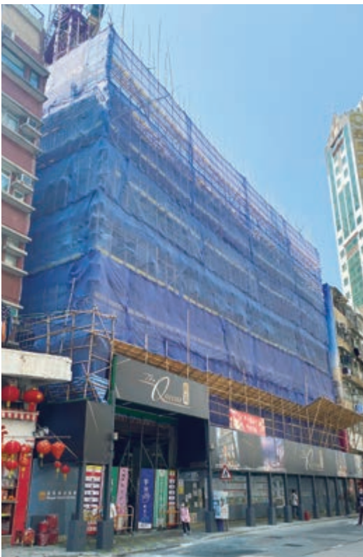
尚隴 — 上蓋建築工程現正進行中
