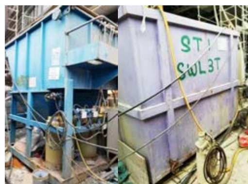
建築地盤的污水處理設施
